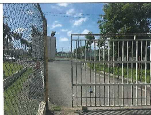
Foto 60. Poste con LBP (4) en portón de entrada área sur
