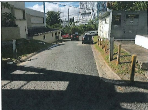
Foto 49. (2) vigas incrustadas en suelo.
