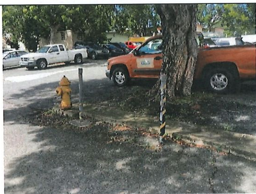
Foto 65. Hidrante y Bolardos con LBP amarillo en estacionamientos. Área Norte.
