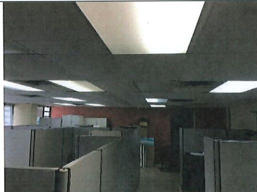
Foto 34. LBP en pared de concreto en Oficina 128
