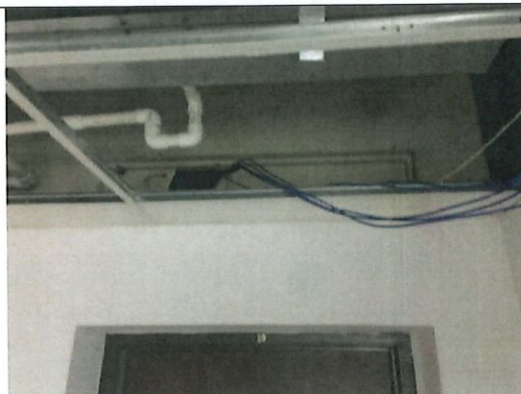
Foto 44. Marco de puerta área Salud Radiológica y Sonósis. Sótano
