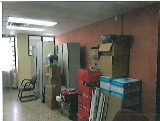
Foto 32. LBP en pared de concreto en Oficina 128
