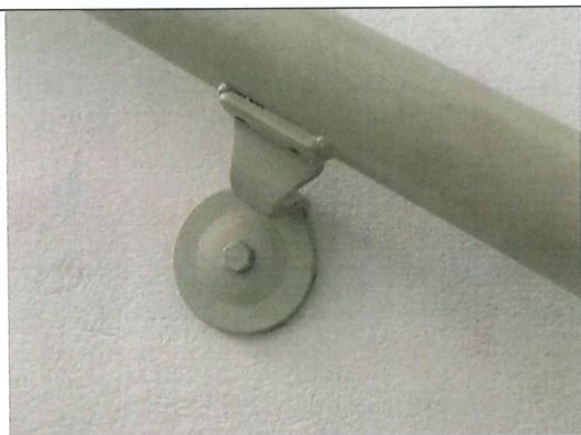
Foto 23 soportes de pasamanos en escaleras de Lab. Higiene.
