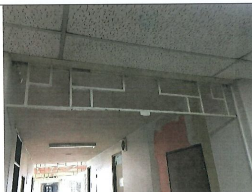
Foto 24 áreas de Rejas de acero. Pasillo hacia Cafetería
