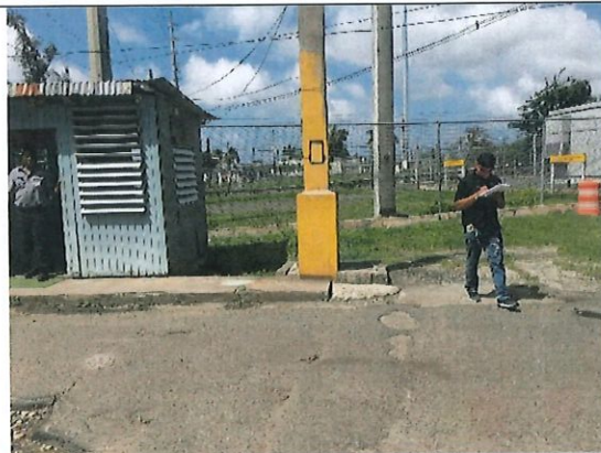
Foto 62. LBP en muro de poste en entrada Área Sur.
