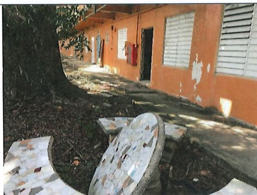
Foto 57. (2 sets) de mesa y banco con LBP en Cerámica. Entre Pabellón 2 y 3.
