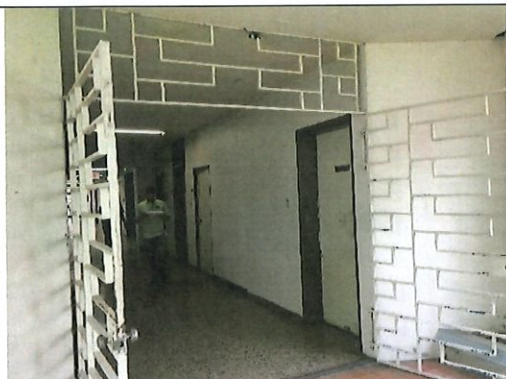
Foto 25. áreas de Rejas de acero. Pasillo hacia Cafetería
