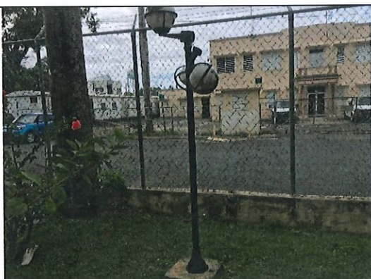
Foto 59. Poste con alumbrado con LBP. Entrada Norte
