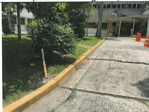
Foto 22. "Bollard" 3 ft entrada.
