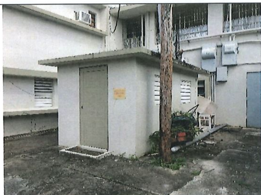
Foto 39. Covacha frente a Subestación Eléctrica. Paredes A, D.
