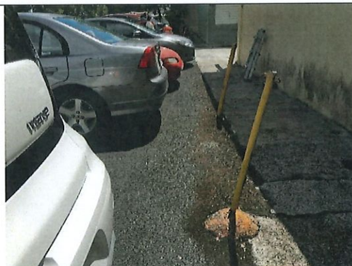
Foto 56. (5) Bolardos y (5) Wheel stop, con LBP en área de Pabellones.
