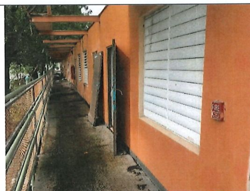
Foto 58. Pasillo Pabellón 2, 2do nivel.
