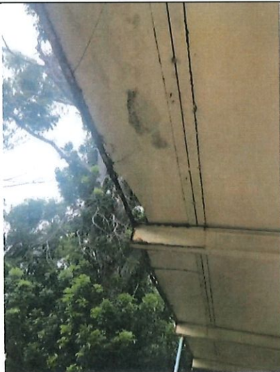
Foto 29. Transite en techo
