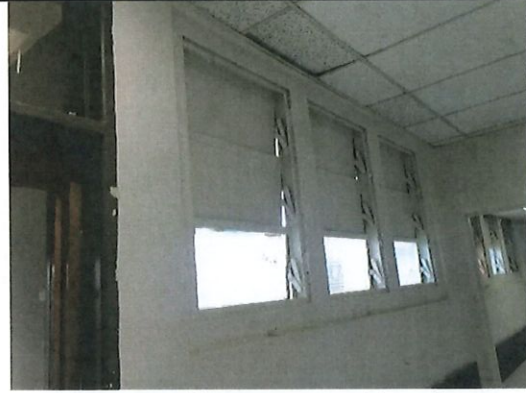
Foto 28. Ventanas con Transite
