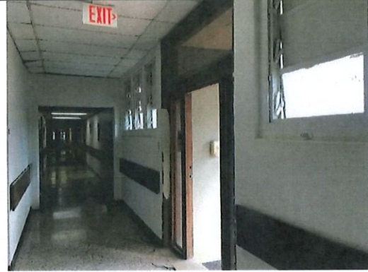
Foto 26. Ventanas con Transite
