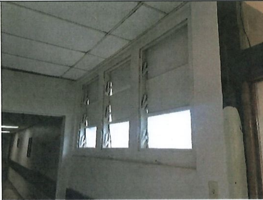
Foto 27. Ventanas con Transite
