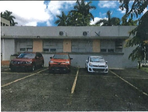
Foto 25. Ventanas con Transite
