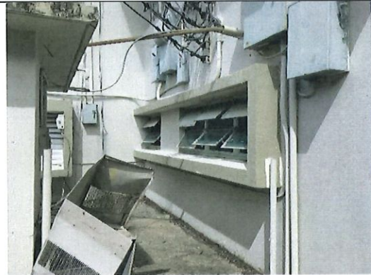
Foto 22. Ventanas con Transite
