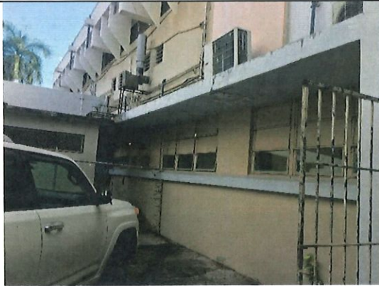
Foto 19. Ventanas con Transite
