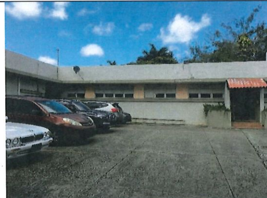
Foto 24. Ventanas con Transite
