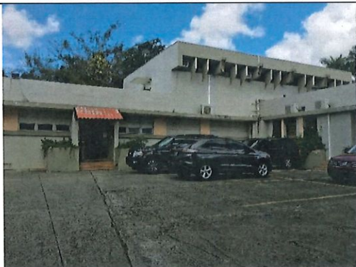
Foto 23. Ventanas con Transite
