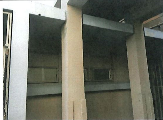
Foto 20. Ventanas con Transite
