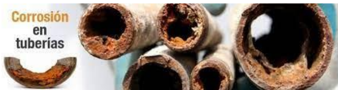
FIGURA 9: CORROSIÓN EN TUBERÍAS-FOTO WEB
