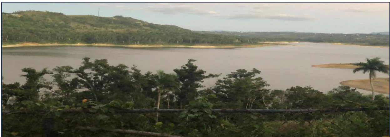
Guajataca Dam, Isabela
